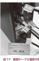
図17 接続ケーブル撮影の例
