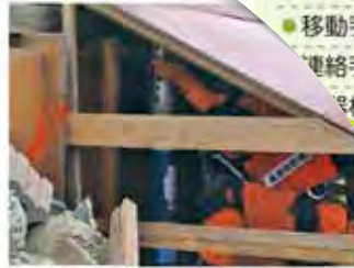
写真9 内部に救助用支柱器具を設定
